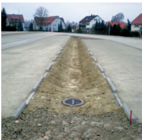
Vsakovací těleso v kombinaci s příkopem
