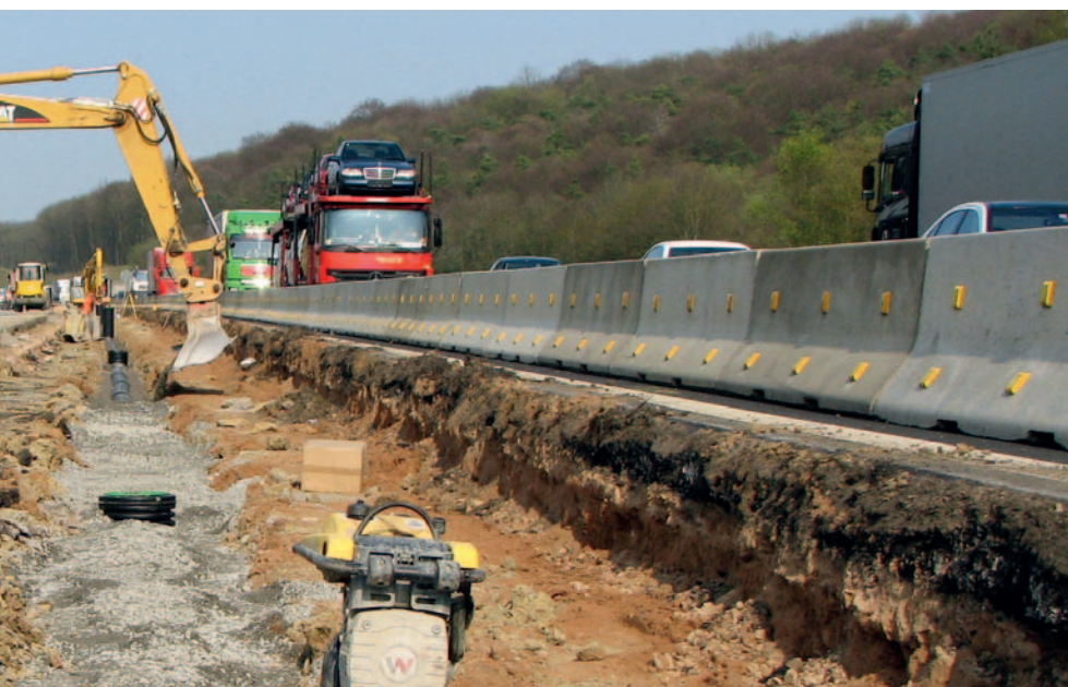
Instalace v dopravou omezeném prostoru
