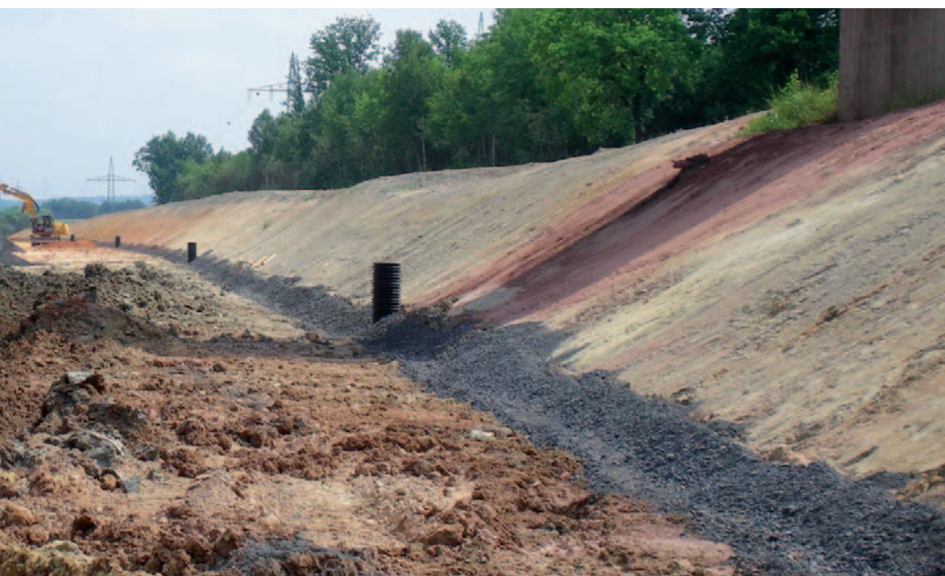
Použití příkopu s malou stavební hloubkou
