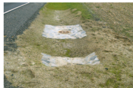
Povrchový vtok osazení v příkopu
