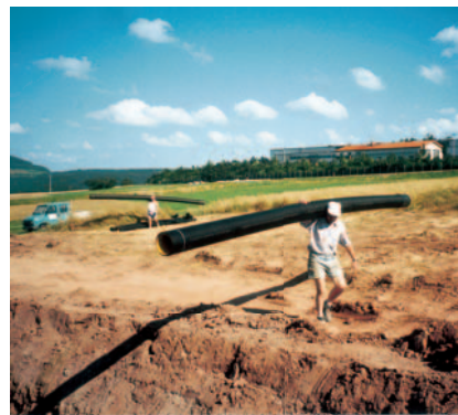
Manipulace na staveništi
